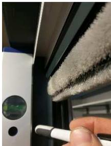
Z vodno tehnico prenesemo vertikalo – na špaleti oz. na površino, kjer se bodo vijačile pritrtilne spojke in jo označimo na obeh straneh.
