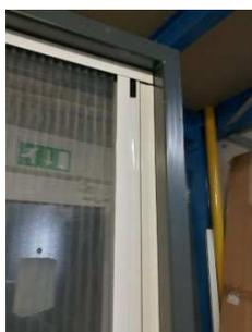
Preizkusimo delovanje. Odprite komarnik, poravnajte mrežico in preverite delovanje plise komarnika. Komarnik se mora odpirati in zapirati brez pretirane uporabe sile. V kolikor so vrvice premalo napete se pri zapiranju komarnika ustvari balon. Komarnik se prav tako ne sme zatikati, v kolikor se, je potrebno preveriti napetost in prostost vrvic, v smislu, da bi bile te ukleščene v prokrovke oz. profil.
