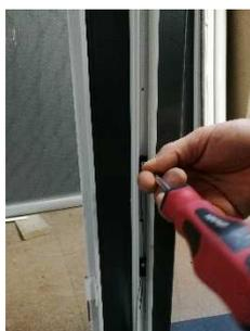
Napnemo vrvice in fiksiramo plastike, ki le-te držijo. Vrvíce morajo biti med odpiranjem in zapiranjem lepo napete, komarnik pa se mora odpirati in zapirati brez pretirane uporabe sile.
