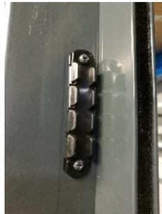
Približno 2 mm od označene vertikale prilepimo in nato vijačimo pritrtilne spojke. V osnovi so spojke pripete na profil.
